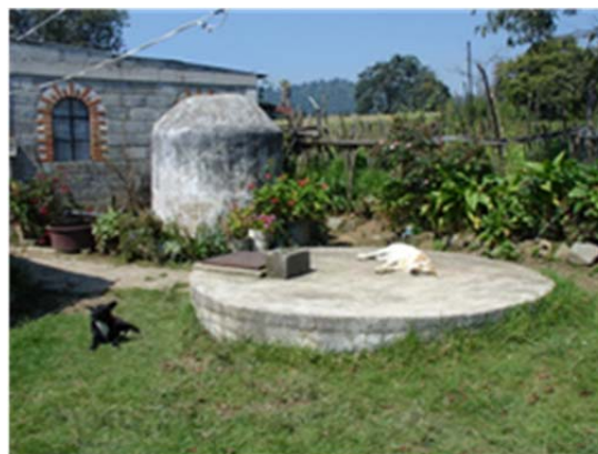
Foto 4. Cisterna ferrocemento y de molde enterrada en casa de la Sra. Modesta Díaz
