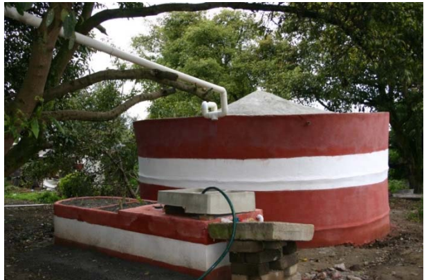
Foto 14. Lavadero y cisterna con conducción y sifón
