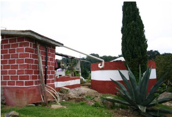
Foto 13. Sanitario seco, lavadero y cisterna de 50m3
