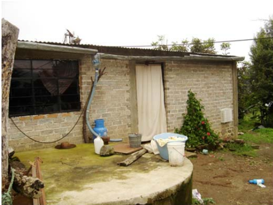
Fotos 7. Cisterna construida con molde
