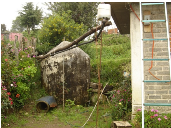
Foto 5. Cisterna de ferrocemento
