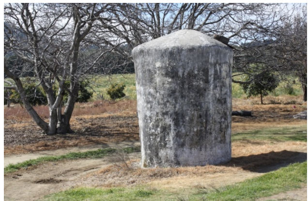
Foto 6. Cisterna de ferrocemento
