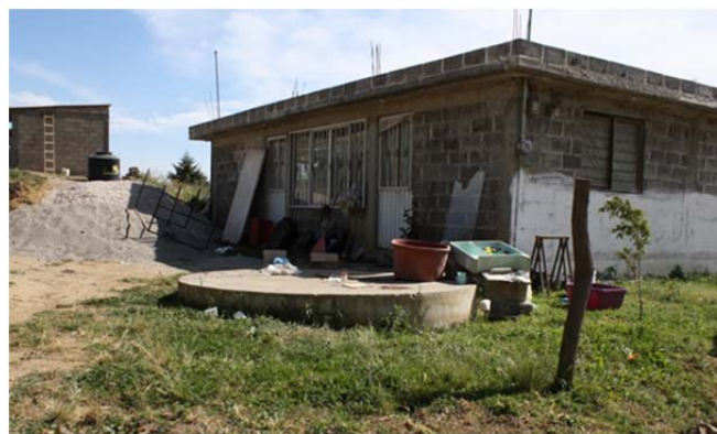
Foto 8. Cisterna enterrada sin captación
