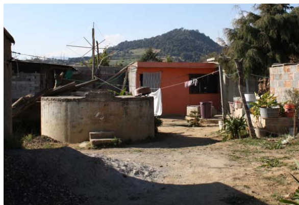
Foto 10. Los escalones al pie de la cisterna facilitan la extracción del agua con botes
