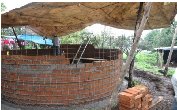
Foto 11. Levantamiento de muros capuchino
