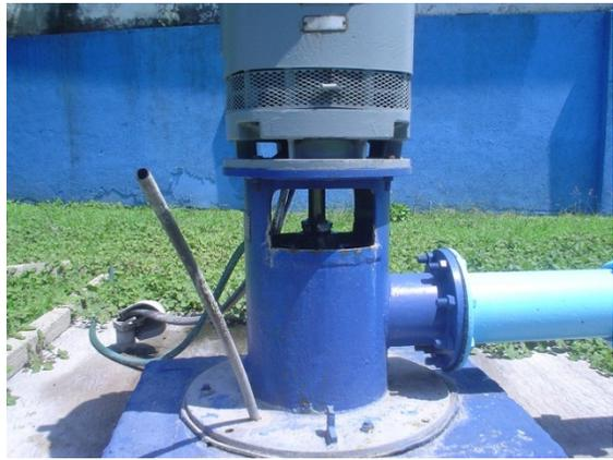
**Figura 4. Tren de descarga en un pozo de agua potable en Puebla.**
